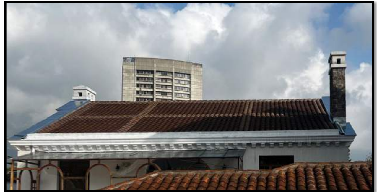
CAMBIO DE CUBIERTA
